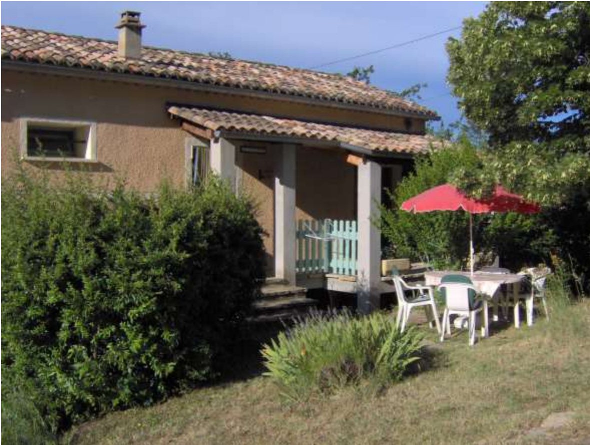
Nordseite mit Eingang
